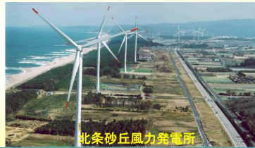
北条砂丘風力発電所
